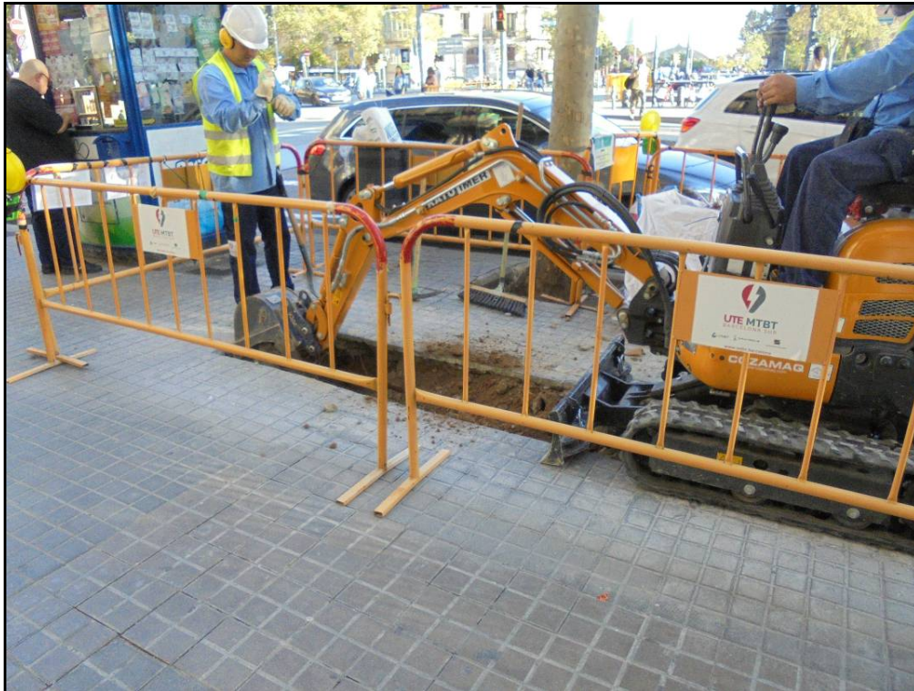
Fotografia 5: Buidatge del sediment de la rasa amb màquina.
