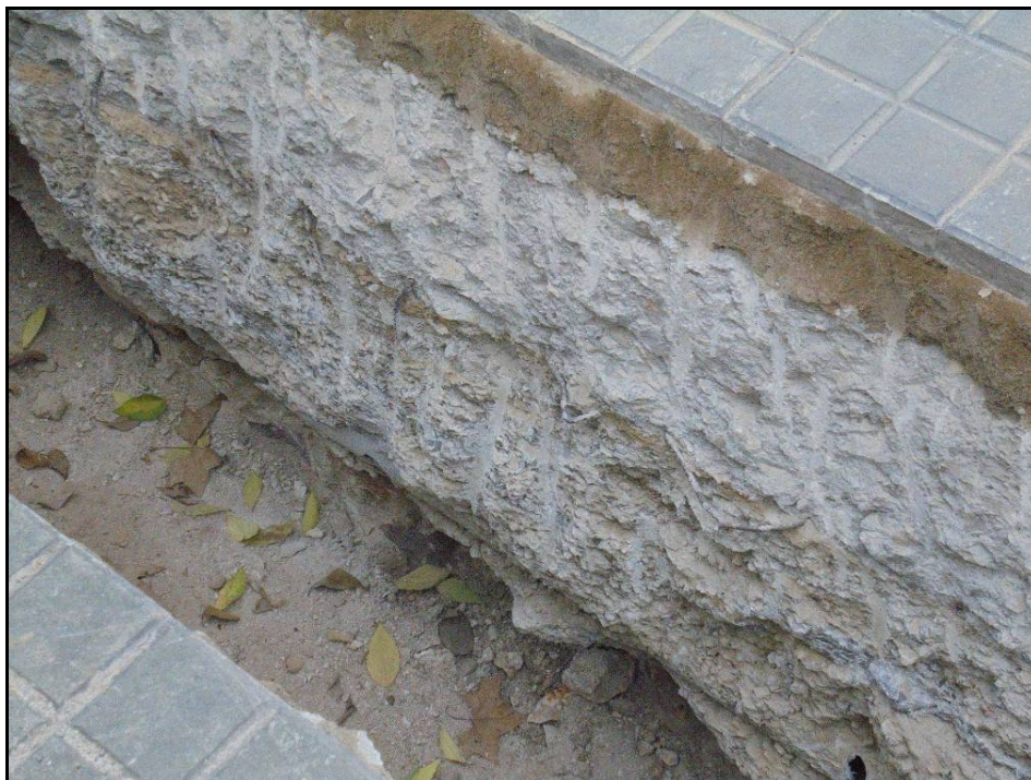
Fotografia 11: Capa de formigó de 40 cm a un tram de Lluís Companys.
