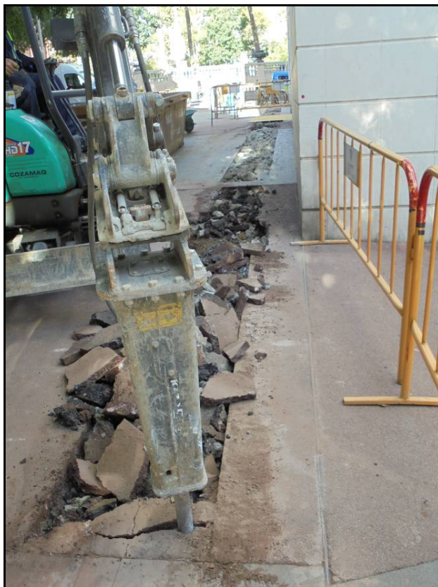
Fotografia 7: Trencament del panot de la vorera amb martell de la màquina.
