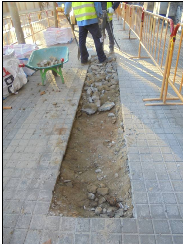
Fotografia 4: Trencament del panot de la vorera amb martell neumàtic manual.
