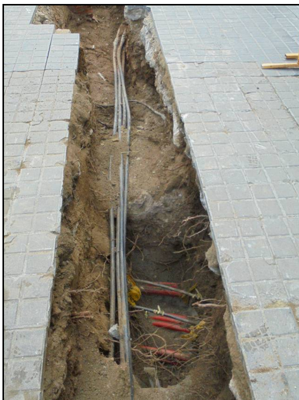
Fotografia 16: Serveis trobats a un tram de la rasa del carrer del Rec Comtal.
