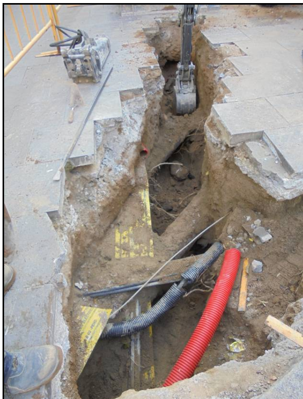
Fotografia 15: Serveis trobats a un tram de la rasa del carrer del Rec Comtal.
