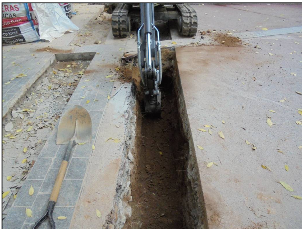
Fotografia 8: Buidatge del sediment de la rasa amb màquina.
